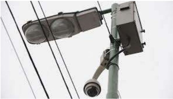
Cámaras de seguridad
